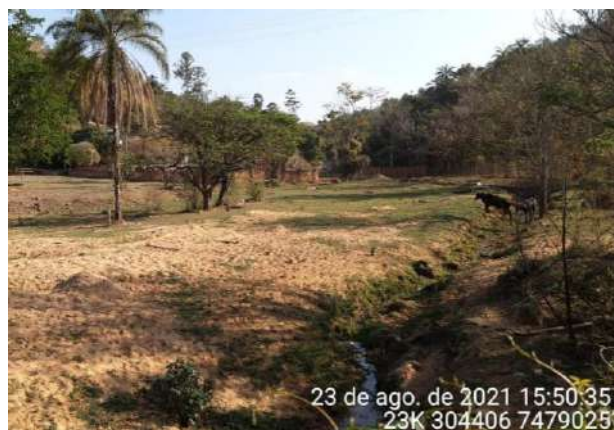
Foto 4 – Drenagem com acúmulo de sedimentos, e exploração de areia. Ponto 5. (23/08/2021).
